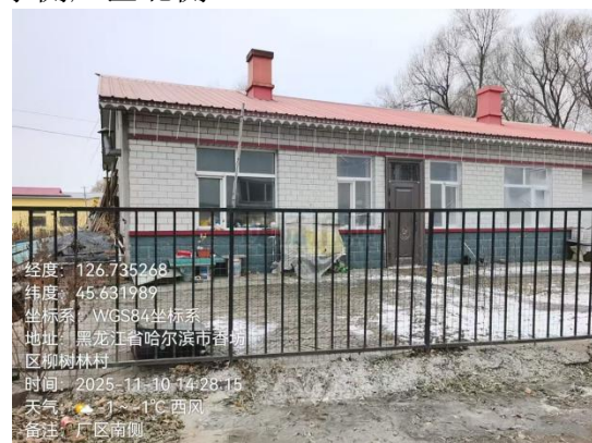
厂区西侧 厂区南侧
