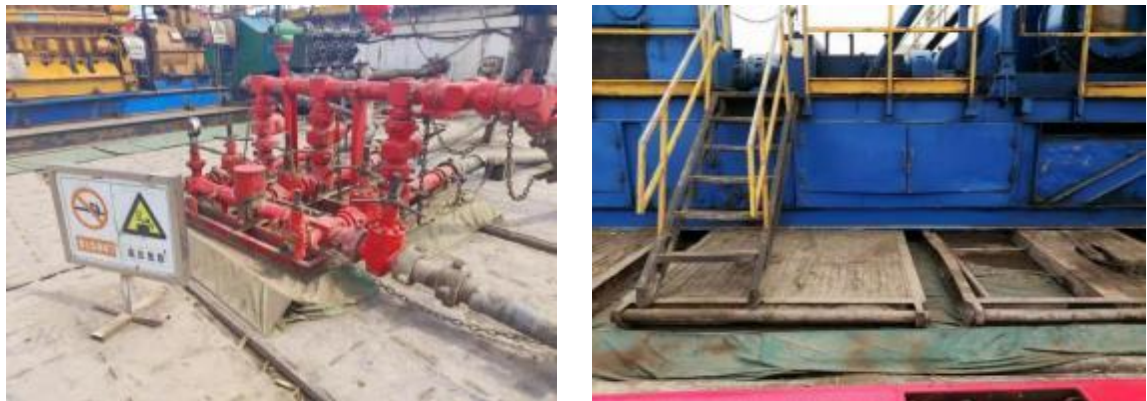
图 4-29 井口和钻井液循环池底部敷设防渗
