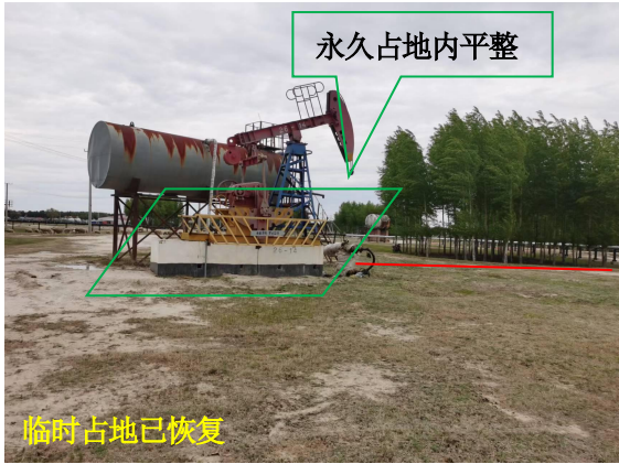
葡浅 26-14 井场及管线占地恢复情况
