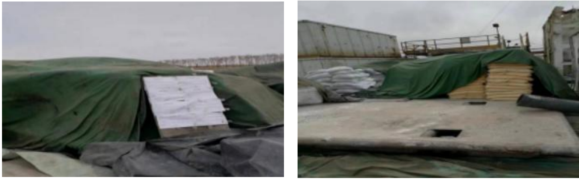
图 4-26 井场重晶石粉等易起尘物料加盖遮盖物
