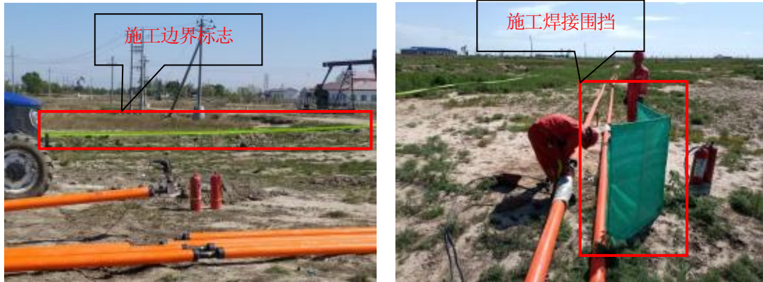
施工生态保护措施
