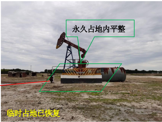
葡浅 27-13 井场及管线占地恢复情况
