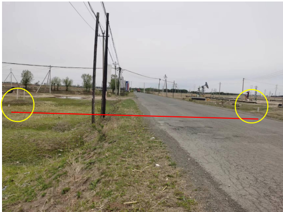
穿越道路集油管道
