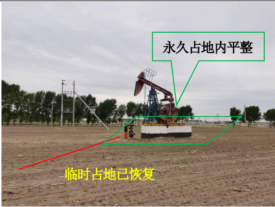
葡浅 28-20 井场及管线占地恢复情况
