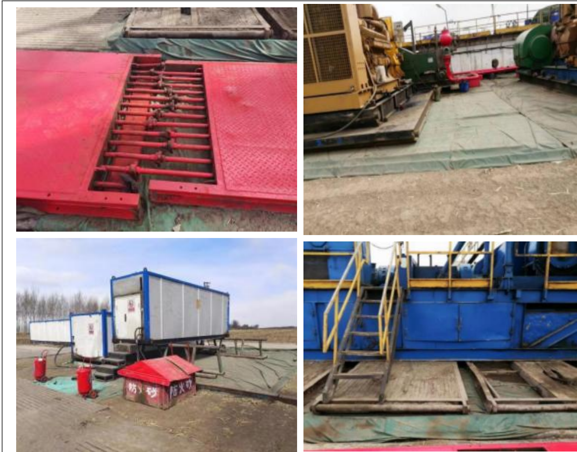
图 4-27 施工期分区防渗情况
