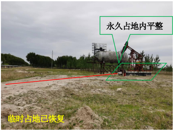
葡浅 27-19 井场及管线占地恢复情况
