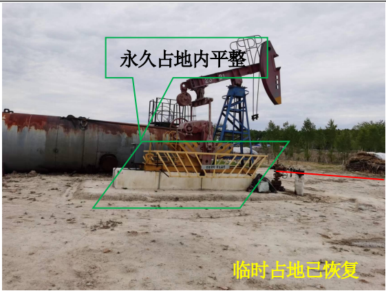
葡浅 23-21 井场及管线占地恢复情况
