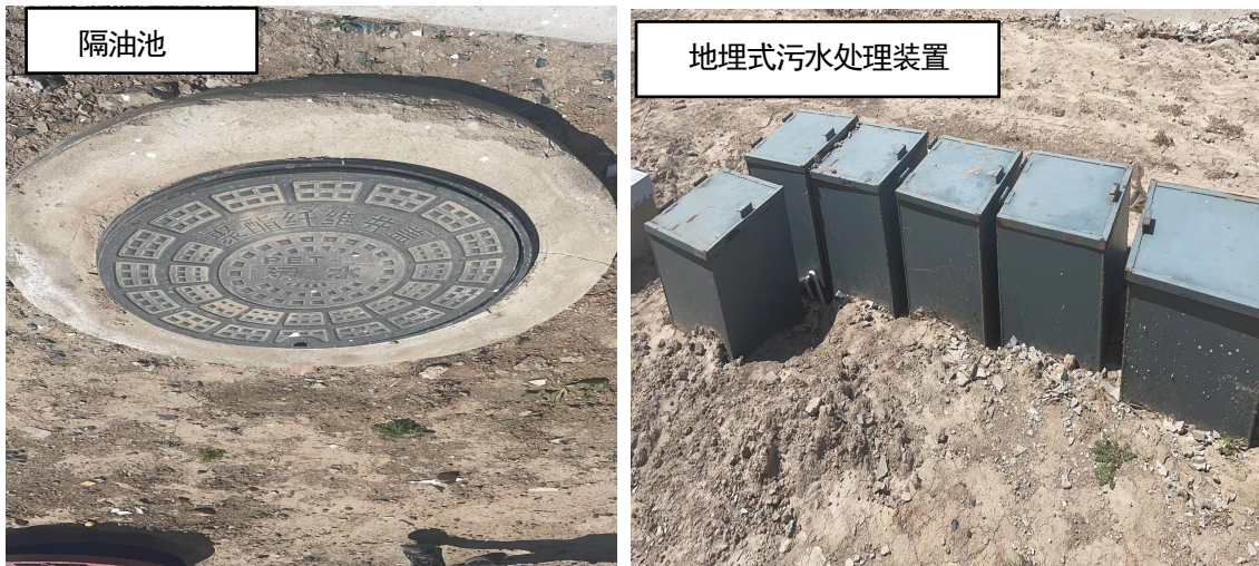
图 4-1 开关站建设情况 调查日期 2023 年 9 月
