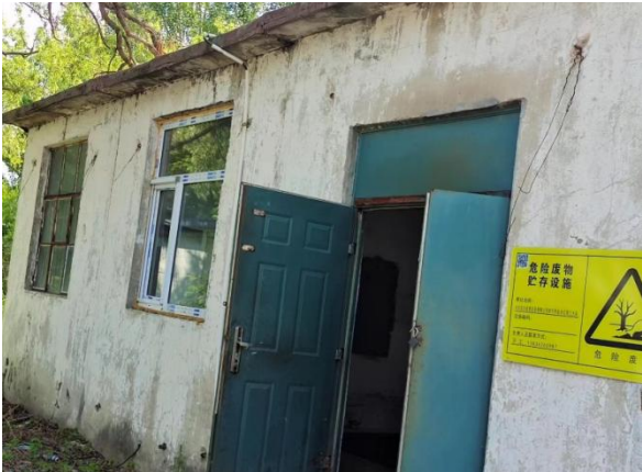
危险废物暂存间
