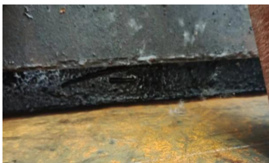
废机油贮存间导流沟
