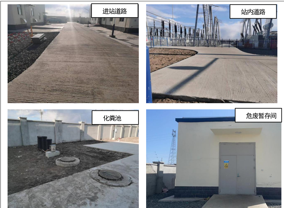
图 4-1 升压站站新建设备设施现状（调查期 2023 年 4 月）
